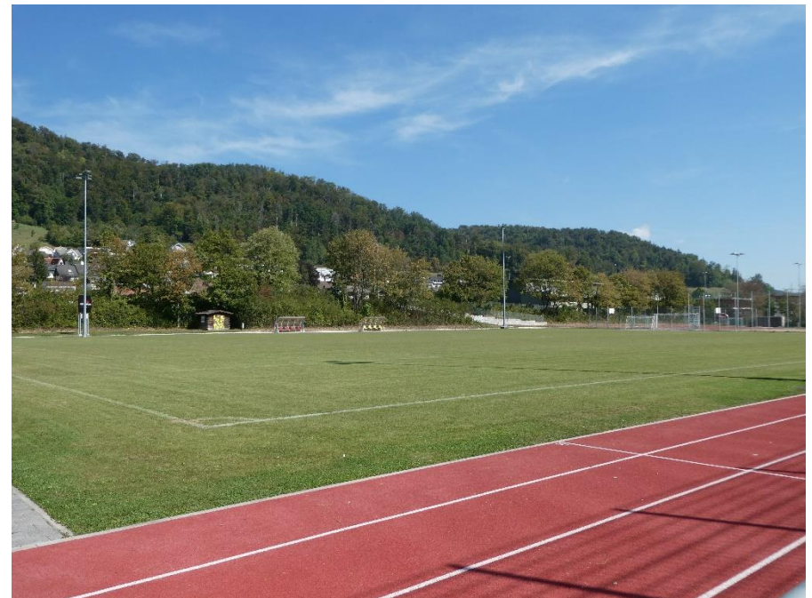
Sanierte Sportanlage Bifang
