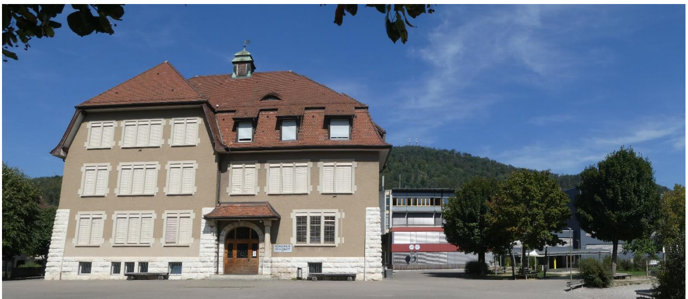
Im Vordergrund das Schulhaus Mühlematt; im Hintergrund die Schulhäuser Bettenach und Grammel.
