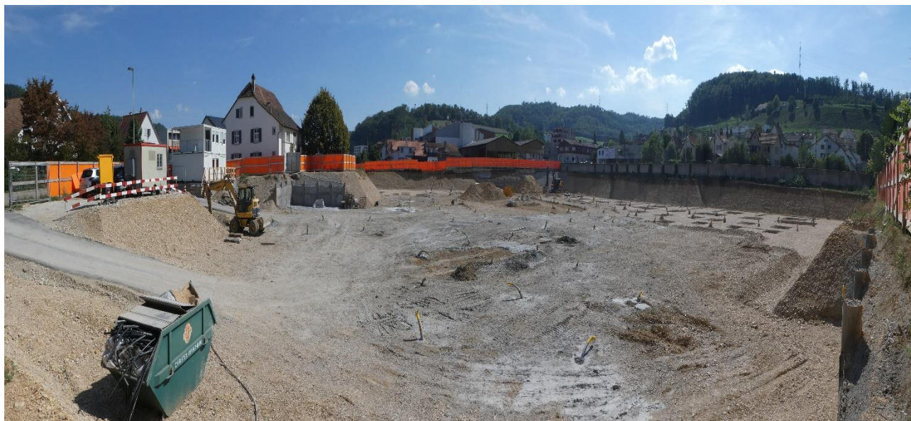
Blick in die Baugrube des Scholer-Areals.
